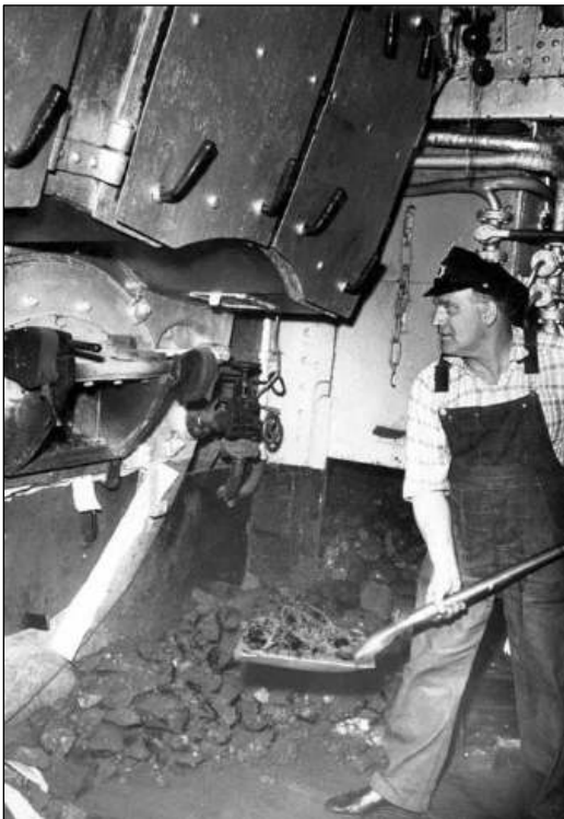
Abb. 3: Die Kohle wird in den Heizkessel geschaufelt.
