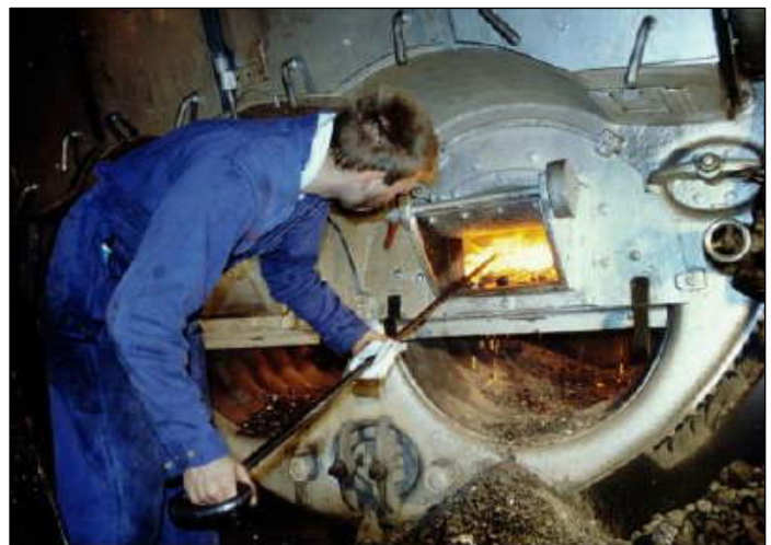
Abb. 4: Die Kohlebrocken im Heizkessel werden durchgerüttelt.
